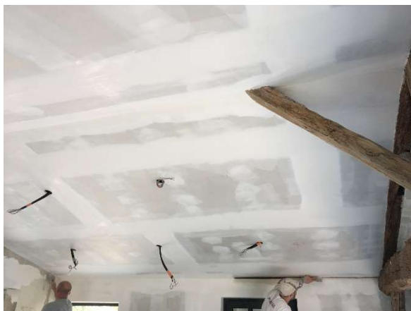
Déploiement des spots de plafond suivant répartition demandée par client
